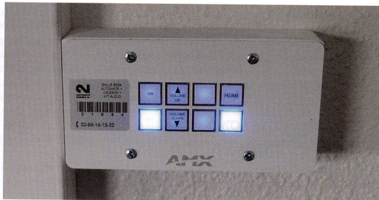
Dans les salles de cours de l'Université Rennes 2, le clavier du mini-automate unifie les commandes de la vidéoprojection, y compris avec des matériels différents. © PA Tafour
